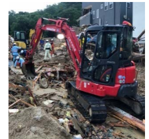
【重機によるガレキ撤去 （広島県広島市）】
