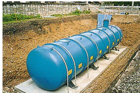
耐震性貯水槽
