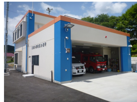
【消防庁舎復旧事業】
