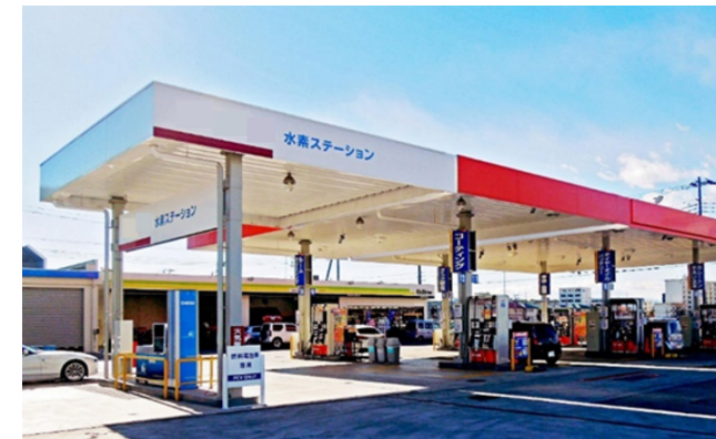
【水素ステーション】
