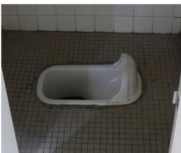
○トイレの整備
